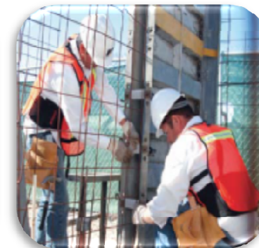
Colocación de discos separadores de acero
