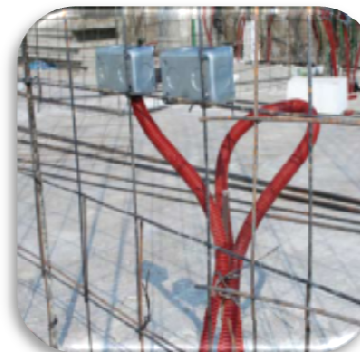
Instalaciones Hidráulicas, Alcantarillado y Eléctricas.
